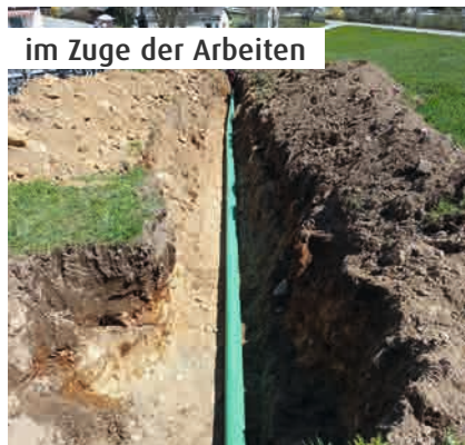
St. Johann, Erschließungsarbeiten Regenwasserleitung
