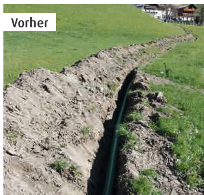
St. Johann, Erschließungsarbeiten Regenwasserleitung
