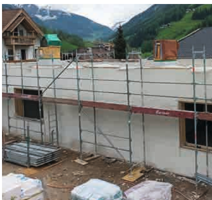
Steinhaus, Umbau Kindergarten
