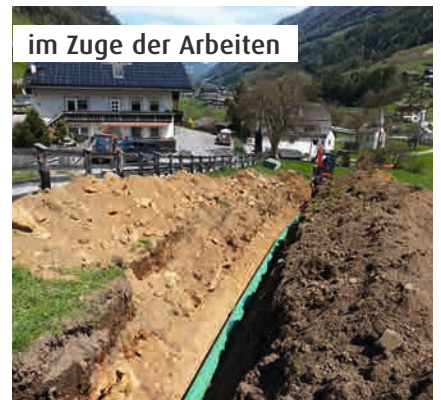
St. Johann, Erschließungsarbeiten Regenwasserleitung
