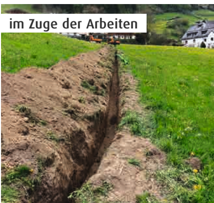
St. Johann, Erschließungsarbeiten Regenwasserleitung
