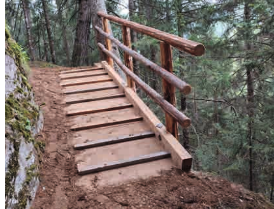
Sanierung von Wegbrücken
