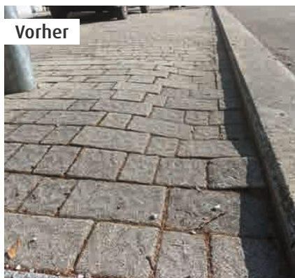
Luttach, Sportbar: Bodenbelag saniert
