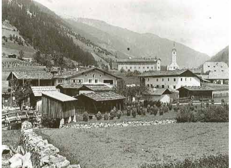
Auch der Dorfeingang von Steinhaus hat sich früher noch ganz anders gezeigt, etwa im Bereich Garber und Garberbrücke. Die Talstraße führte direkt vor dem Garberhaus vorbei.
