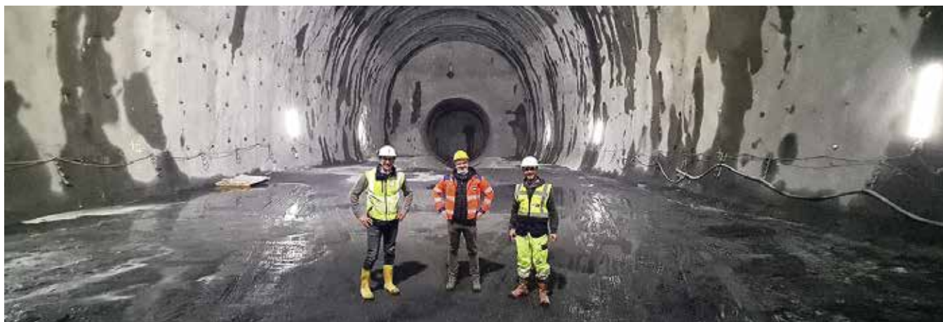
Arbeit untertage: hier die fertiggestellte Startkaverne für die Tunnelbohrmaschine beim Projekt Brennerbasistunnel
