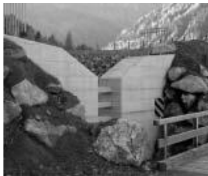
Schutzdamm Kahle - Weissenbach
