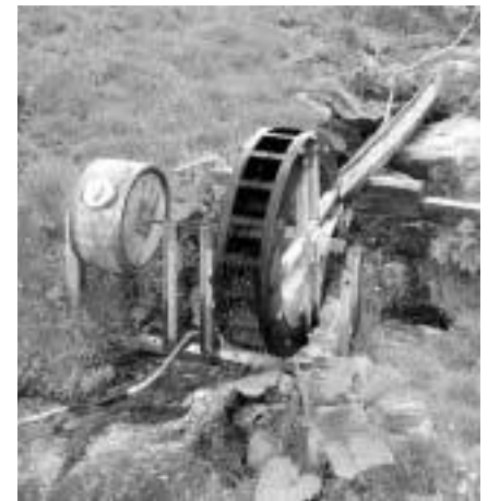
Wasserrad mit Butterrührkübel: ein einfaches Werk, kostenfrei und umweltschonend
