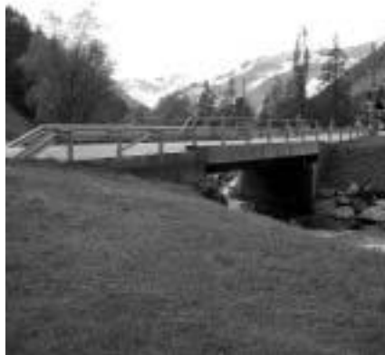
Die Brücke bei der Pizzeria „Kreuzwirt“ in St. Jakob; um- bzw. neu gebaut im Jahre 2004. Erstmals errichtet wurde sie nach dem Unwetter von 1867.
