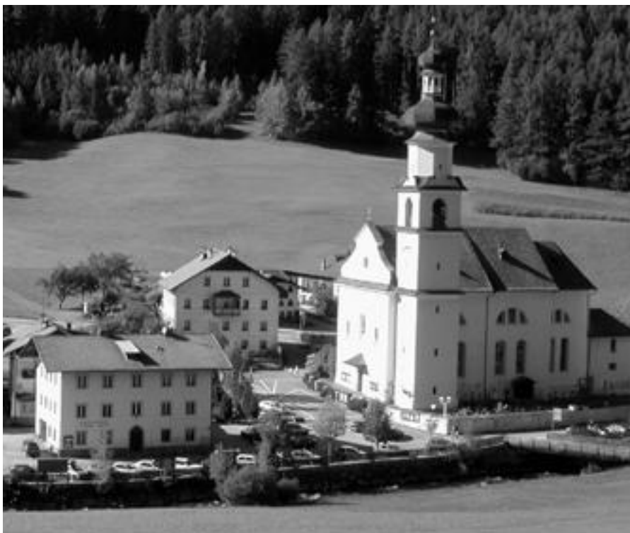
Vor dem Abbruch der alten Mittelschule
