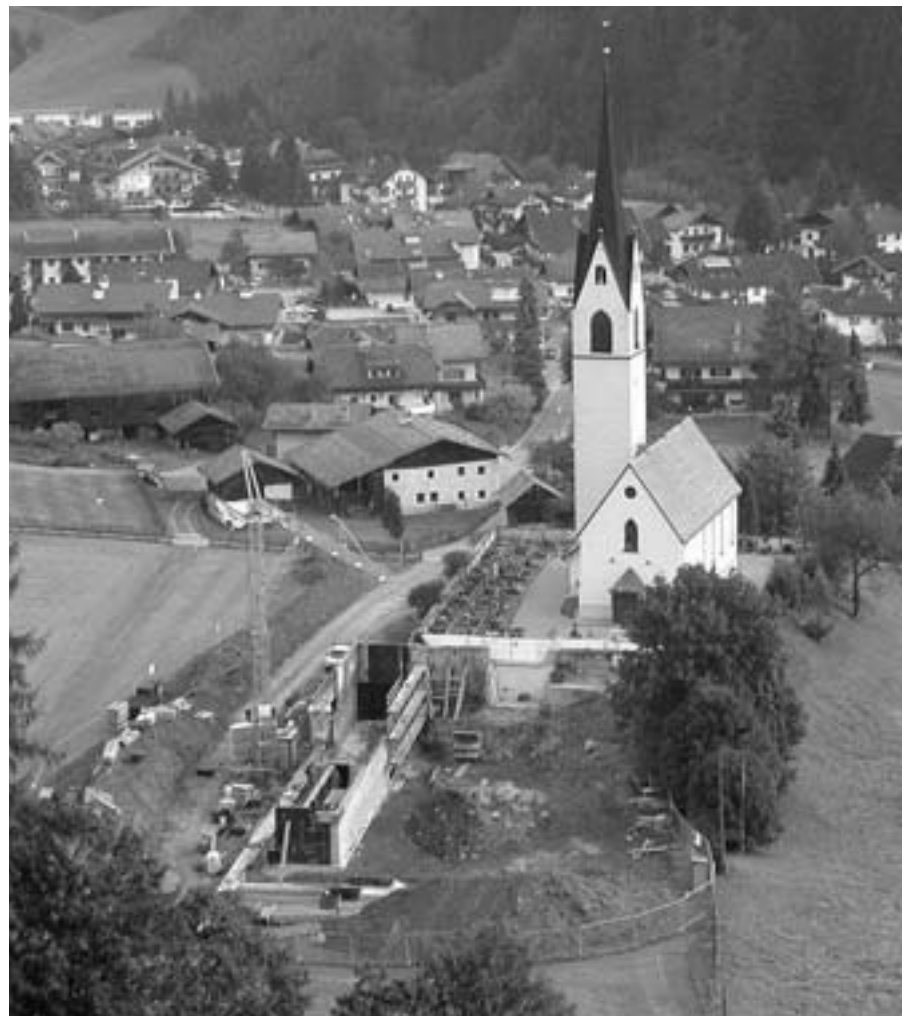
Die Arbeiten für die Friedhofserweiterungen in Luttach haben begonnen
