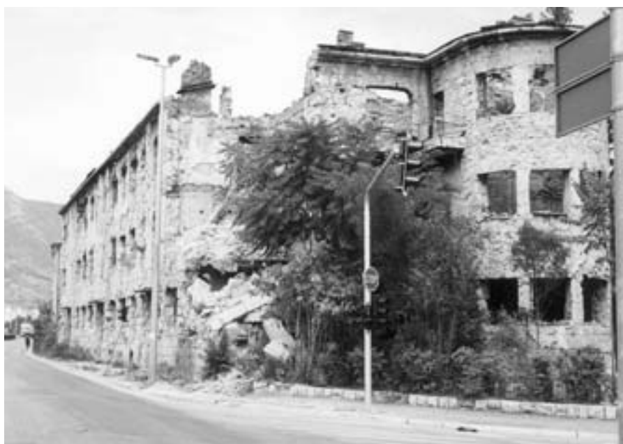
An der Frontlinie: Bulevar in Mostar
