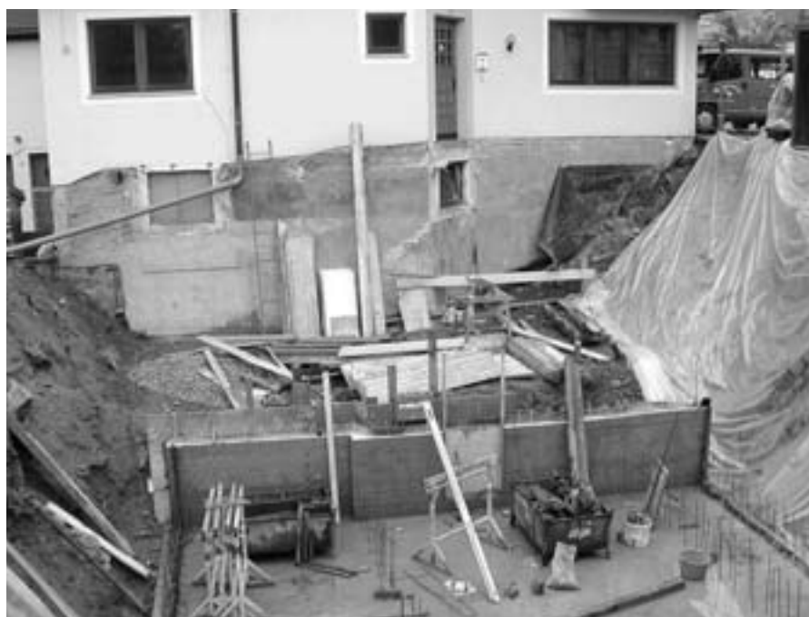
Die Station des Weißen Kreuzes in Lutttach steht vor der Fertigstellung
