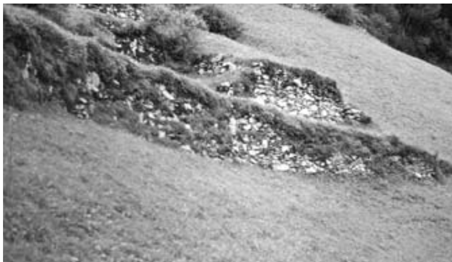
Brüchige Feld- und Trockenmauer
