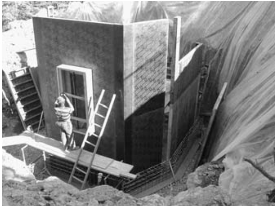
Bau der Wasserstube im Bärenal
