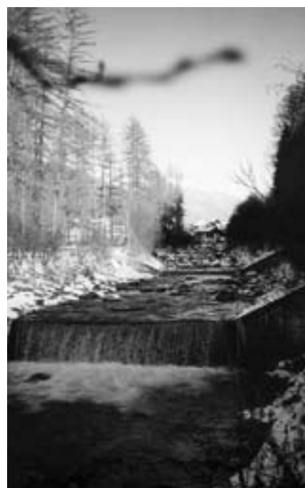
Im Bild der in Frage kommende Abschnitt der Ahr für die Staustufe St. Jakob
