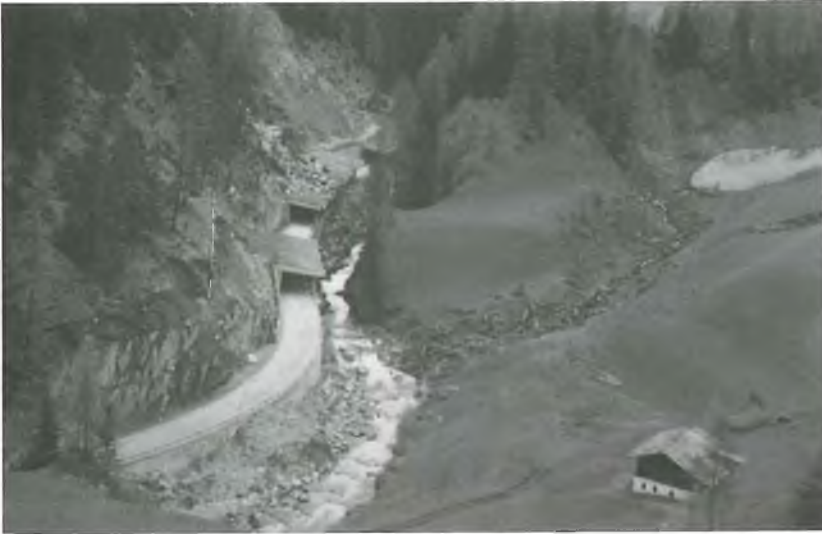
Mehrere vor Jahrzehnten erbaute Gelerien machten die Durchfahrt durch die Klamme etwas sicherer. Lawinenreste im Jahre 1975
