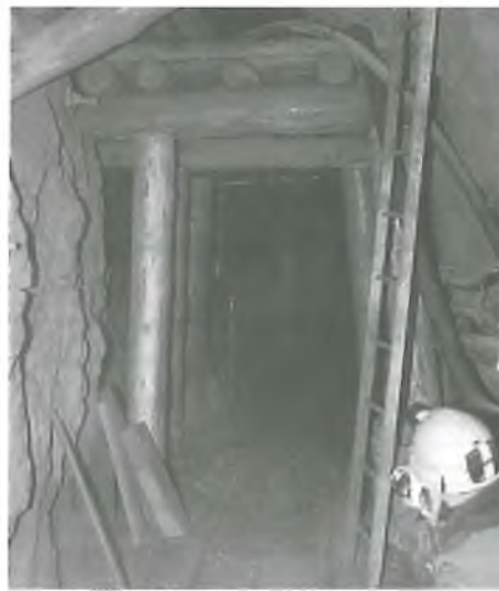
Neue Stollenzimmerung auf Sohle 6 (kleiner Rundgang)
