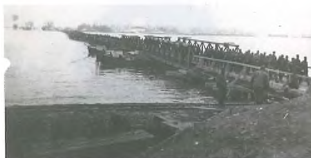
Eine 800 m lange Pontonbrücke über die Donau bei Listiawa (rumänisch-bulgarische Grenze). Aus dem Wehrpaß: "April 1941: Einmarsch in Bulgarien, Durchbruchsschlacht durch die Metaxaslinie, Eroberung von Saloniki." Bei einer Rast in einem Straßengraben durch Partisanenbeschuß in höchster Lebensgefahr.
