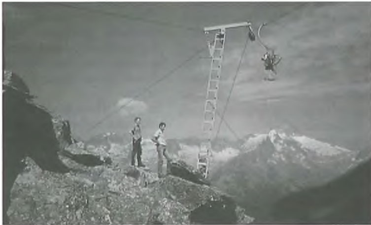
Kontrollgang an der Lawinensprengbahn im Sommer
