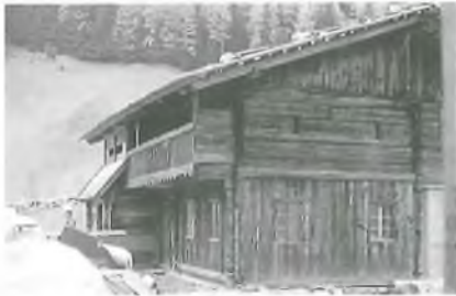
Schienenhaus, ehemalige Knappenbehausung
