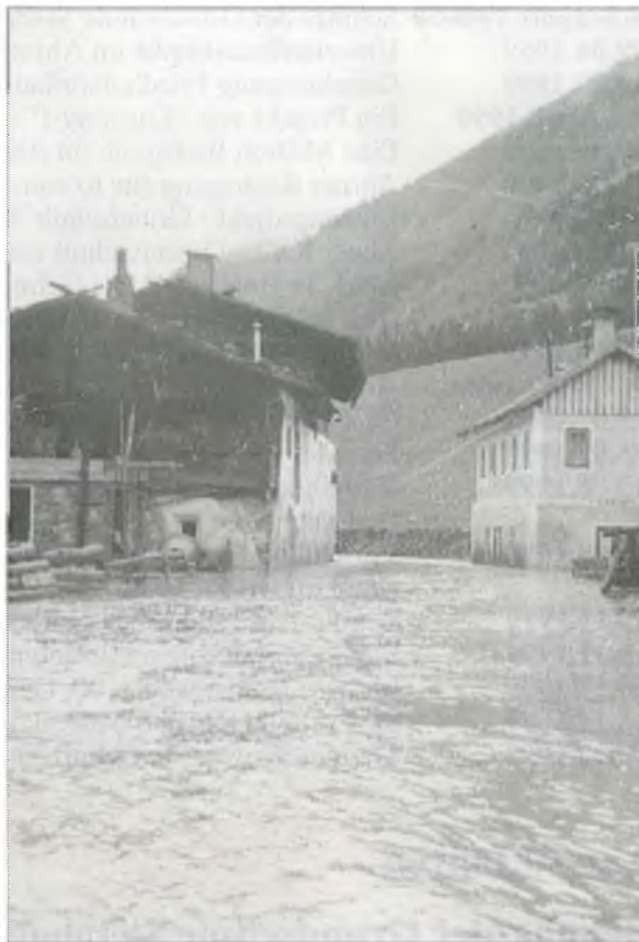
Die überflutete Hauptstraße oberhalb vom Batterer, Unterschachen und Schachenhäusl
