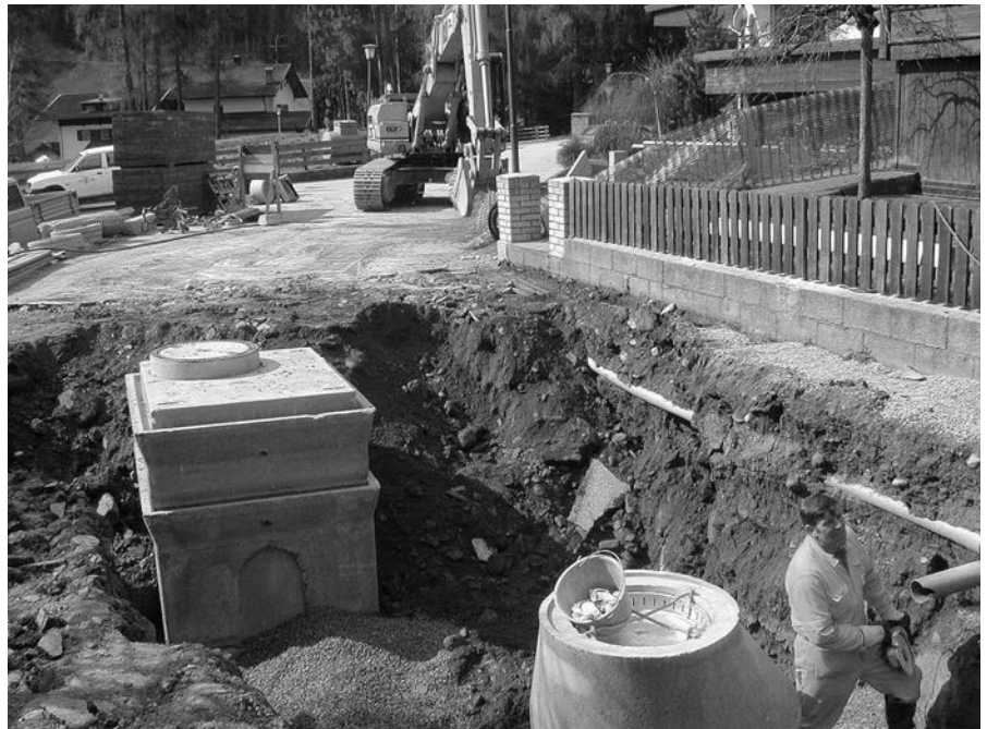
Sanierungsarbeiten an der Kanalisation in der Wohnbauzone Maurlechn in Luttach
